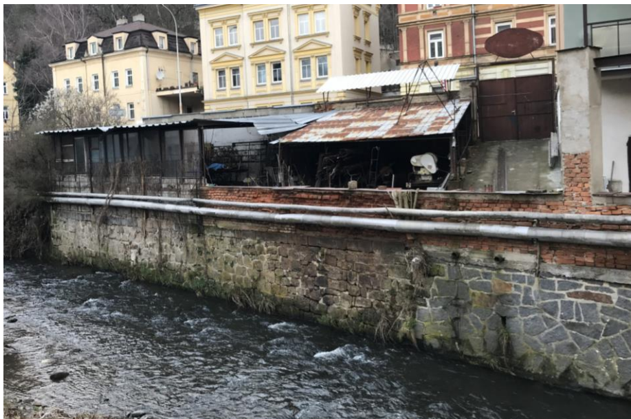
Foto č. 6: Pohled po směru toku na poškozenou část zdi v patě (úsek řešen předpatou)
