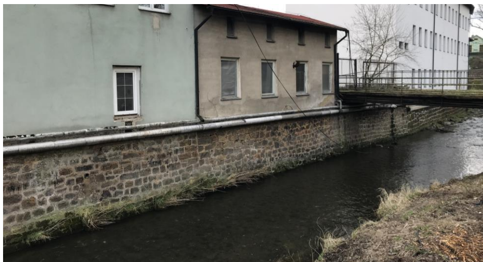
Foto č. 6: Pohled po směru toku na poškozenou část zdi v patě (úsek řešen předpatou)
