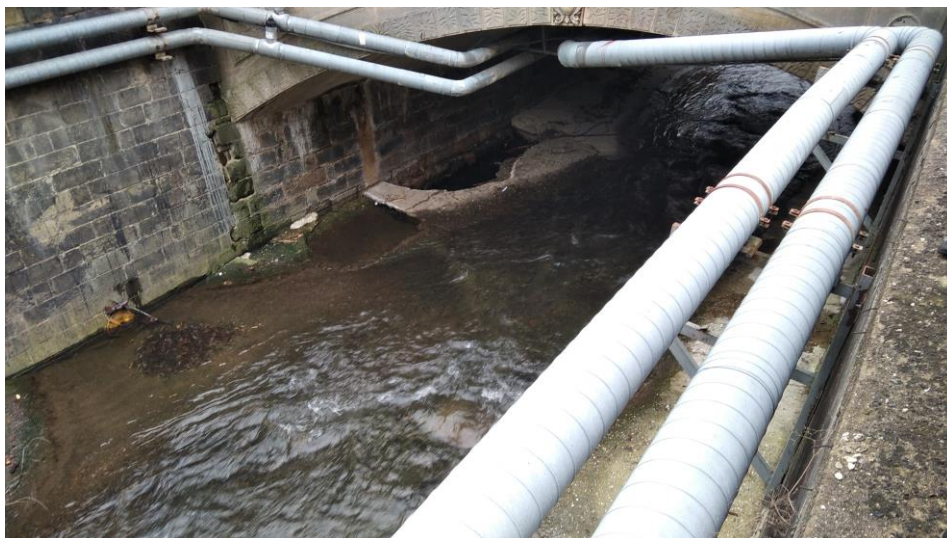
Foto č. 1: Pohled na poškozené dno pod mostem v ulici Jungmannova (Děčín)
