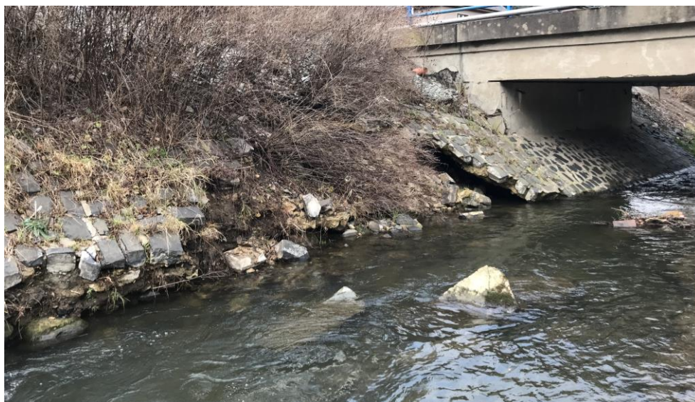
Foto č. 9: Pohled po směru toku na poškozený břeh a dno
