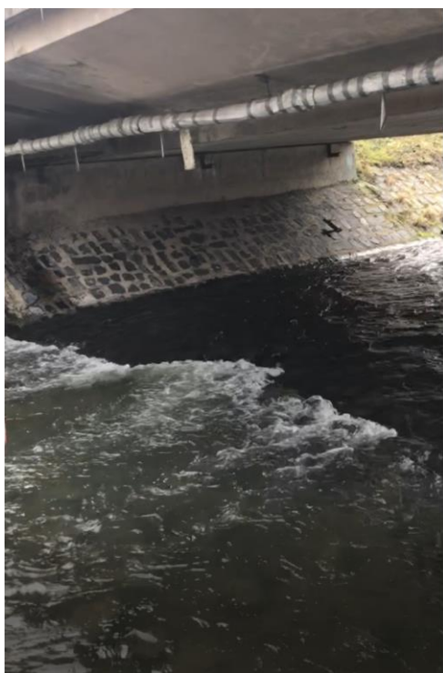
Foto č. 8: Pohled proti proudu na poškozenou dlažbu ve dně pod mostem
