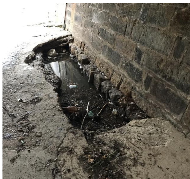
Foto č. 3: Pohled proti směru toku na spodní poškozenou část
