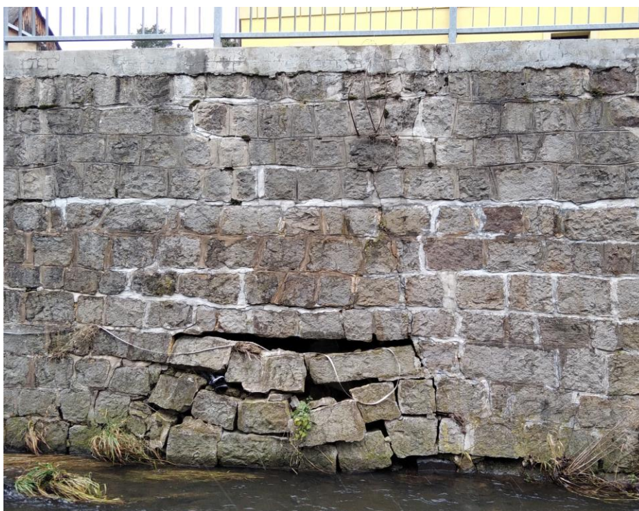
Foto č. 14: Pohled poškození zdi
